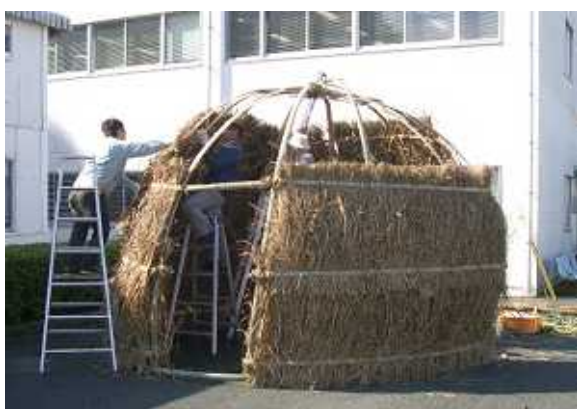
写真3：「竪穴式住居」の建築過程（建築デザイン学科）（出展物の一事例）
